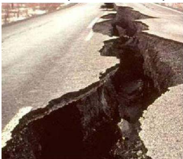
Figura 4: Cedimento della carreggiata a seguito della espansione laterale del suolo (Alaska, 1964)
