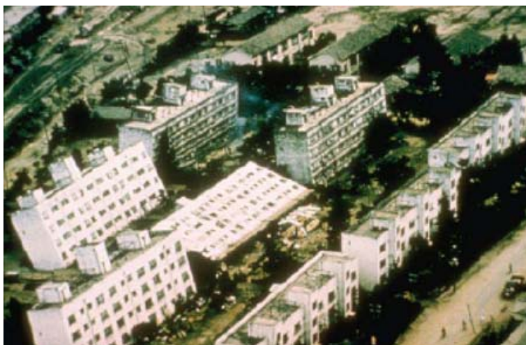
Figura 1: affondamento di edifici nella città di Niigata (Giappone, 1964)
