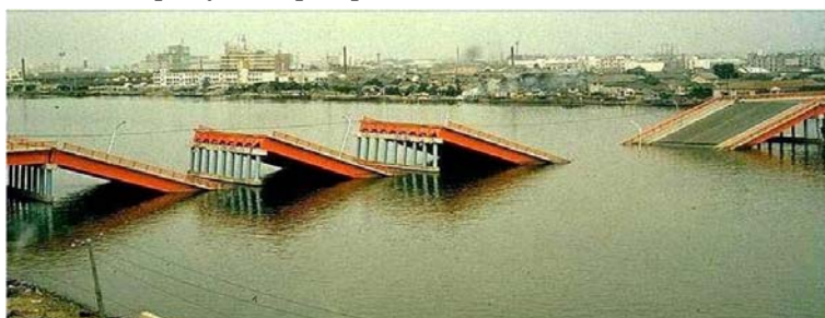
Figura 3: cedimento del ponte Showa nel corso del terremoto di Niigata (Giappone,
